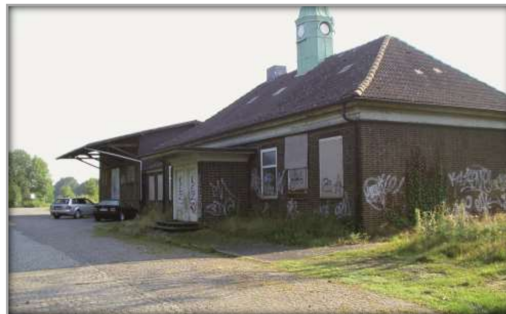
Empfangsgebäude vor der Sanierung
