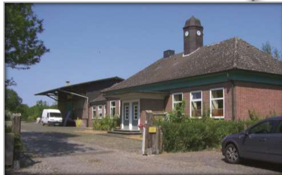
Empfangsgebäude nach der Sanierung
